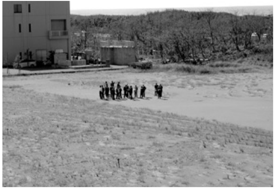
第2期工事はじまる(南部浄化センター)
