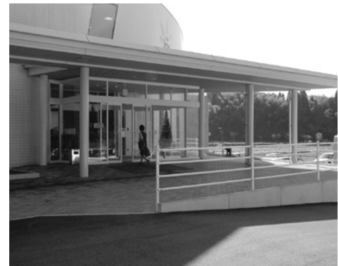
改修予定のエントランス (ジョイアクロス)
