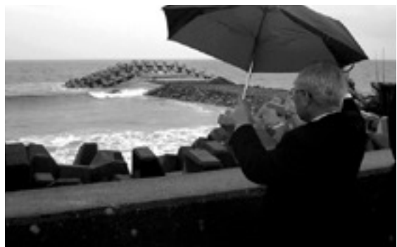
ヘッドランド工法による養浜
