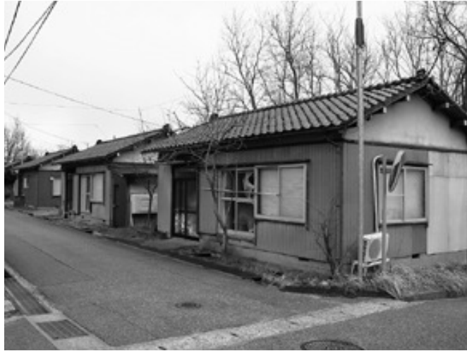
老朽化が進む (中沼団地)
