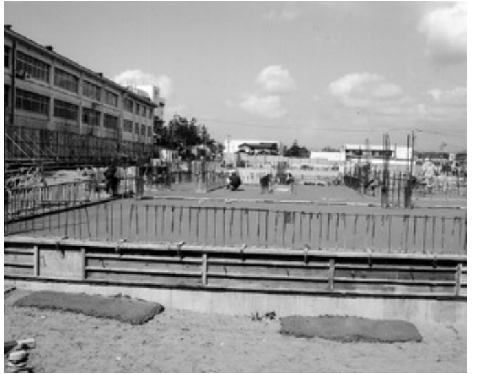
建設が進む宇ノ気中学校
