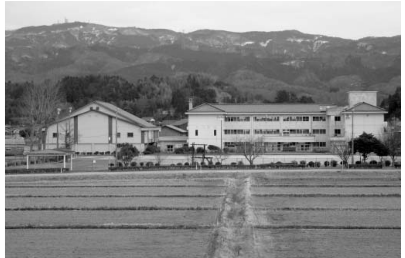
大海小学校体育館（写真左）を耐震化
