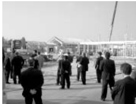
学園台保育園建設工事（高松北部）
