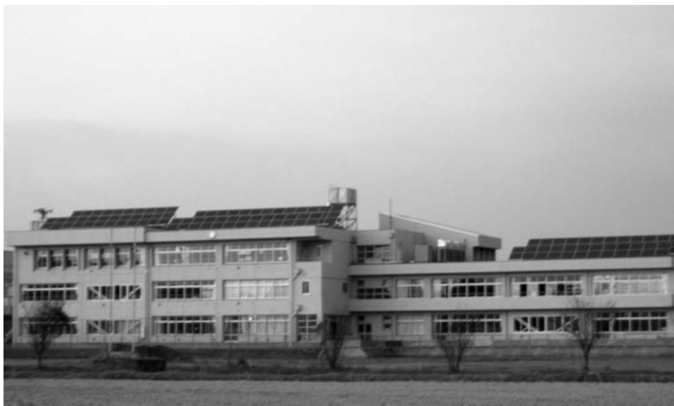
太陽光パネル設置の樋川小学校（宝達志水町）
