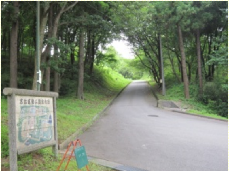
幅員6mに拡大される道路(高松運動公園内)
