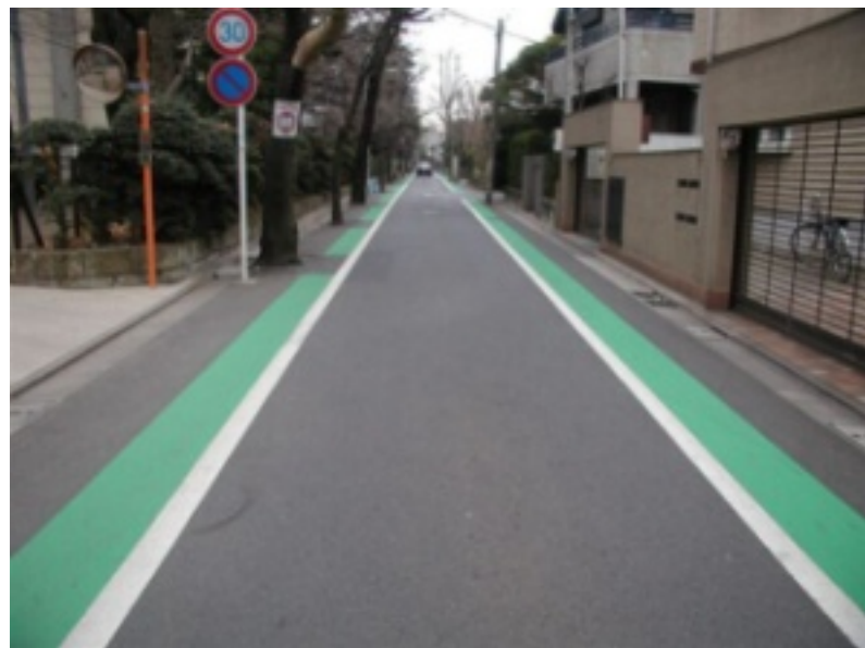
安全性の高いカラー歩道
