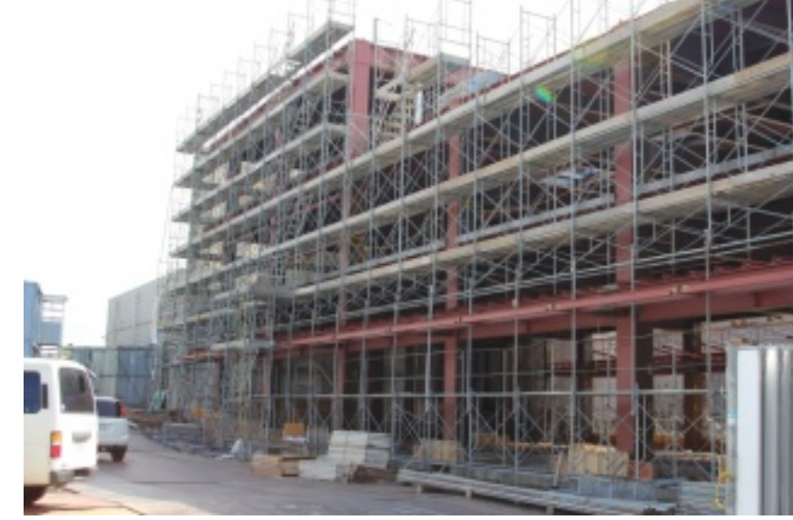
建設中の（仮称）高松多目的施設
