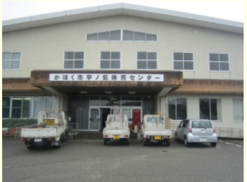
大規模改修する宇ノ気体育センター
