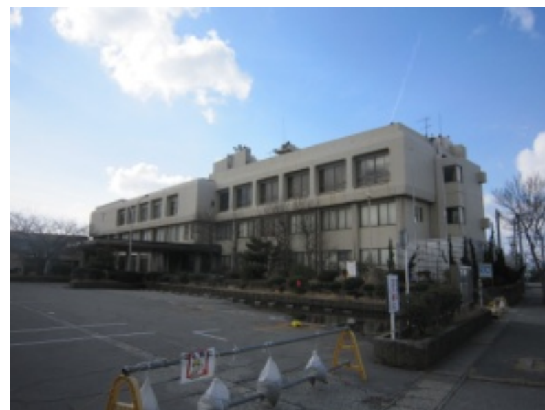
老朽化し、雨漏りがひどい七塚庁舎
