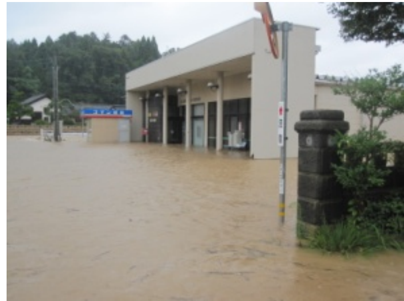
冠水した旧JA金津支所
