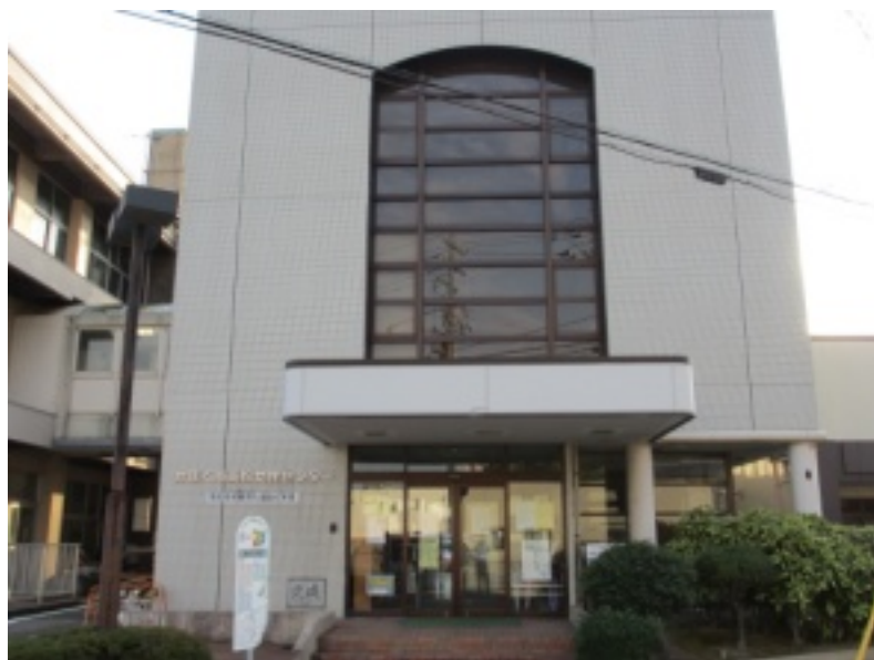
解体する高松女性センター
