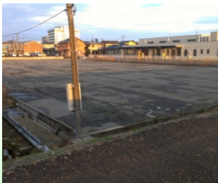
調整池・ポンプ設備予定地（七窪地内）
