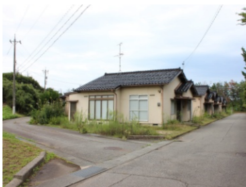
取壊しされる老朽市営住宅
