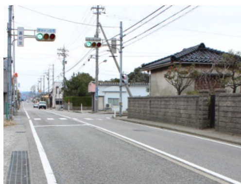
国道159号(高松地内)
