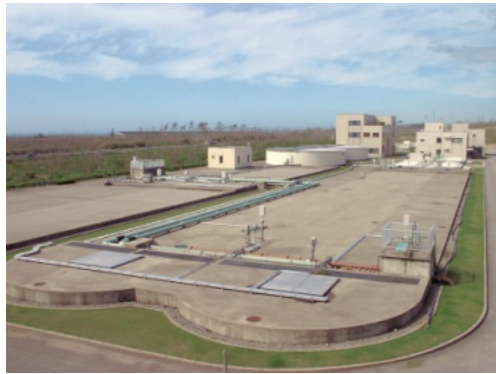
下水道施設（南部浄化センター）
