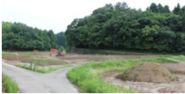
ほ場整備事業が進む市道気屋1号線付近
