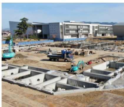
総合体育館第1期工事
