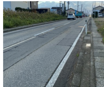
国道159号（高松地内）
